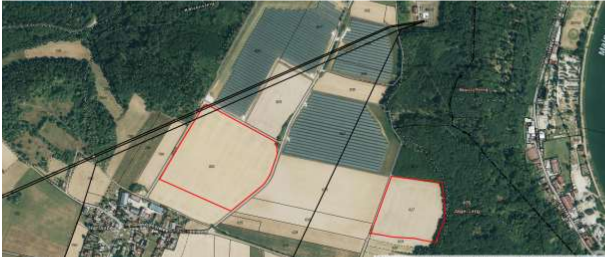
Landschaftsbild (Quelle: Bayernatlas) - rot umrandet: Geltungsbereich des Bebauungsplanes; schwarze Linien: 20- und 110 kV-Freileitungen
