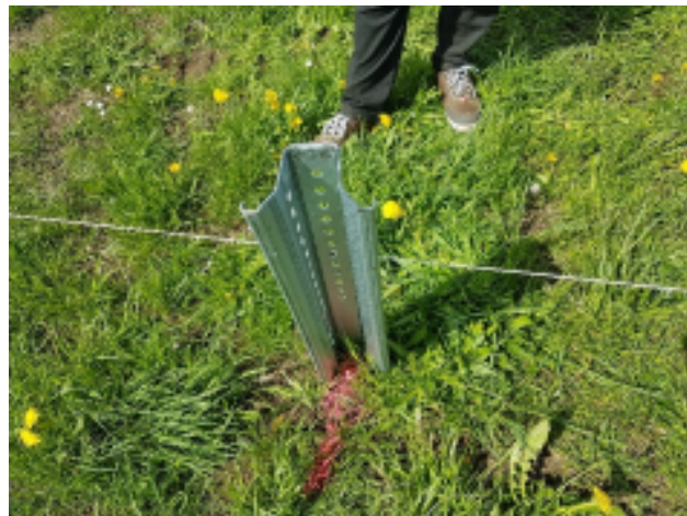
Abbildung 5: Rammfundament
